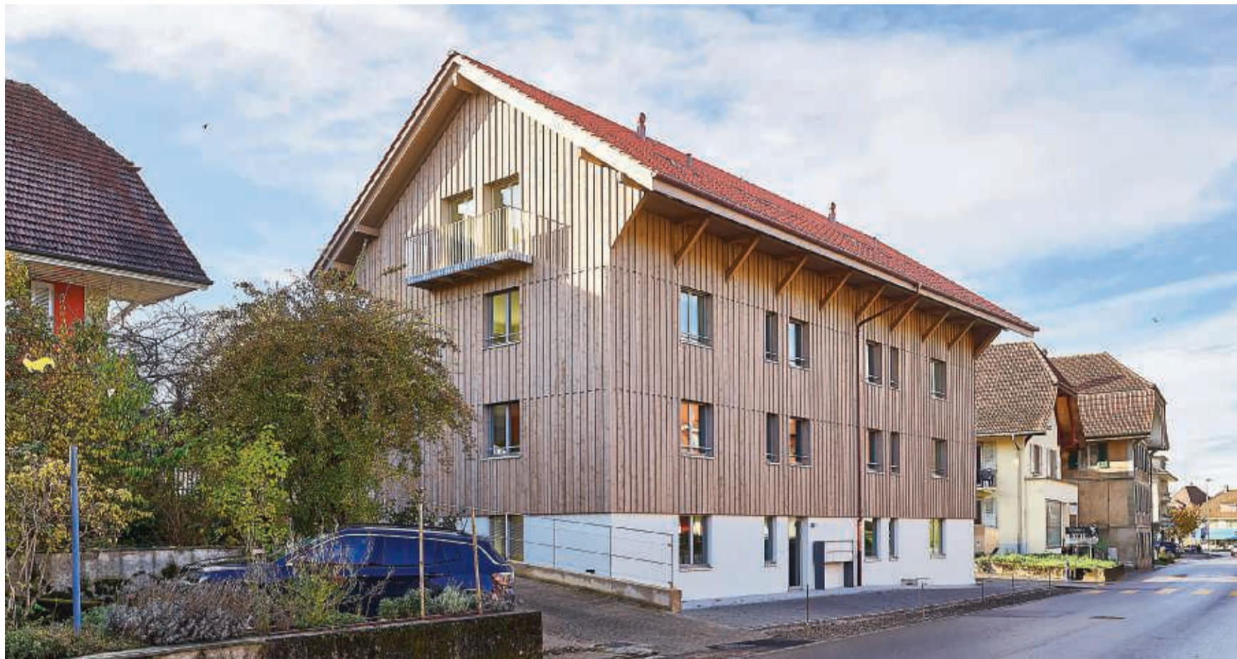
Ein gelungener Ersatzneubau im geschützten Dorfkern. Das Haus passt in die geschützte Dächerlandschaft.
