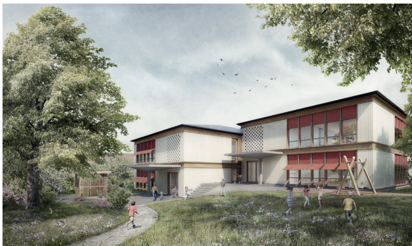
Complexe scolaire à Herzogenbuchsee, 1er rang 2021, en cours de réalisation
